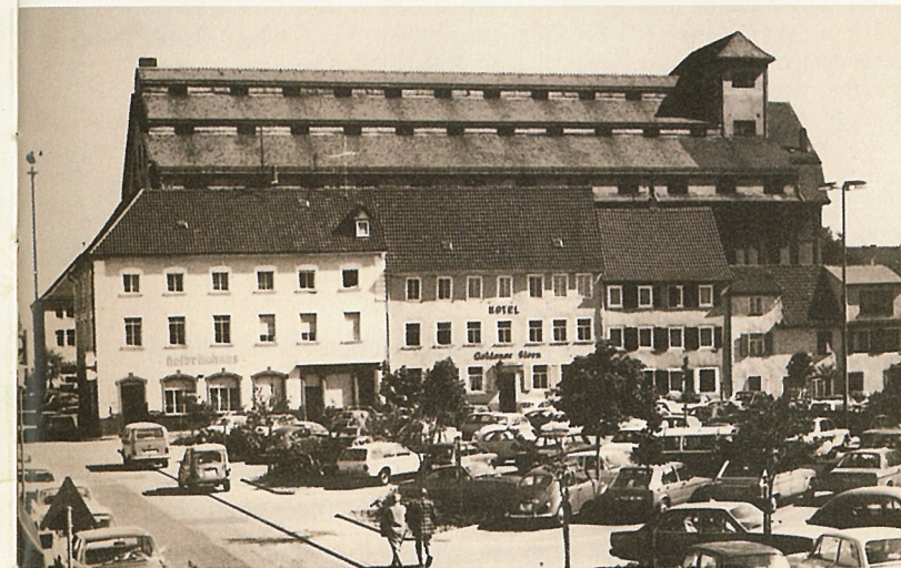
Das Hafermagazin (gebaut 1914-16)
