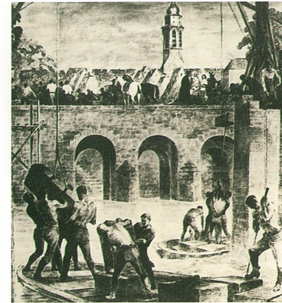
Bau der Einlaßschleuse am Queich
