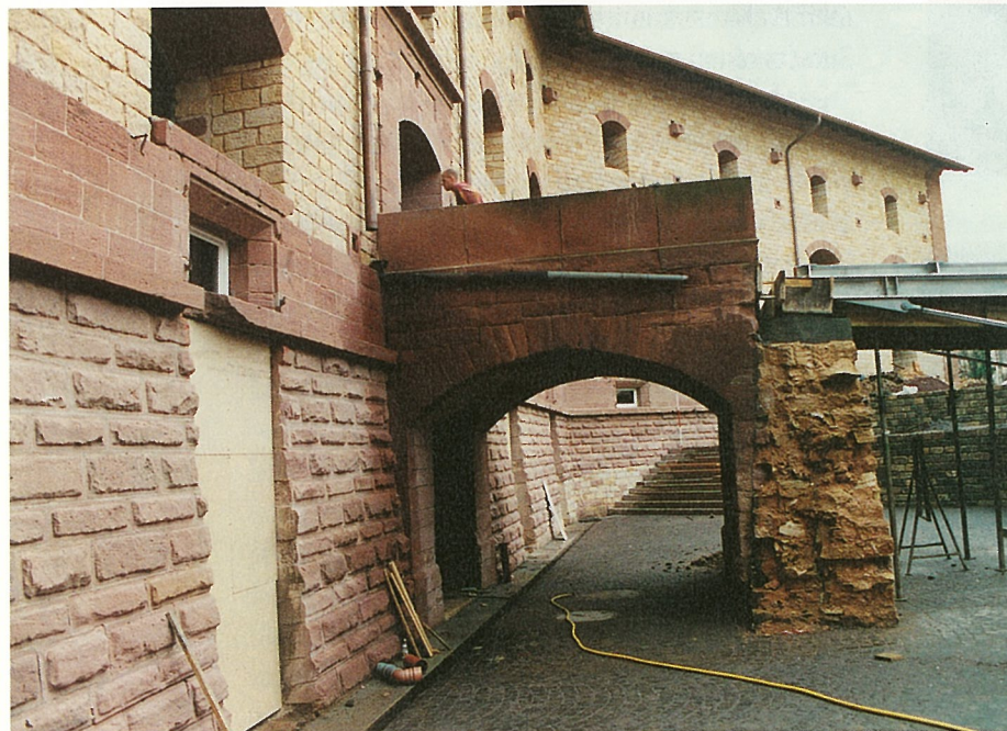
Die Veränderungen an der Substanz, z.B. Ausschneiden von Fundamenten, müssen Schritt für Schritt vor Ort geplant und entwickelt werden, ...
