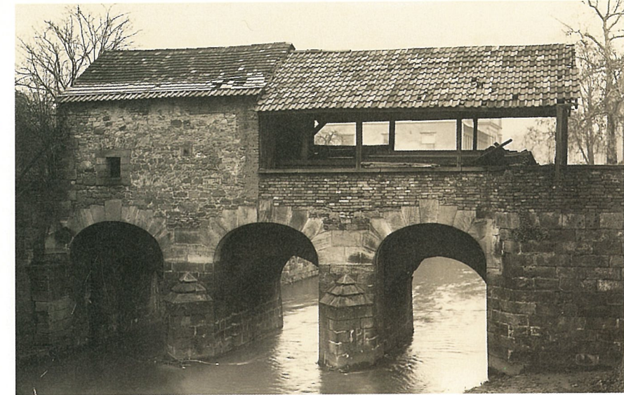
Auslaßschleuse am Reduit 13
